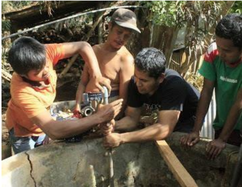
Pemasangan Pompa Air di Balai Desa Tambak dibantu oleh warga sekitar
