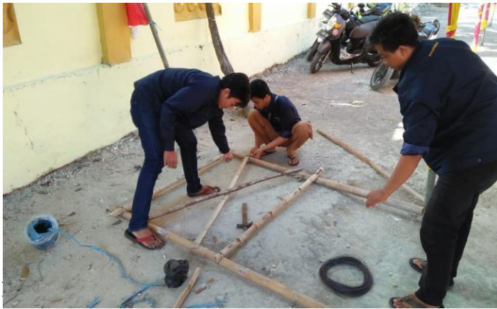
Pemasangan Plang untuk Nama Balai Desa Tambak
