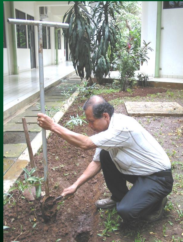
5 Pengangkutan tanah hasil pengeboran LRB
