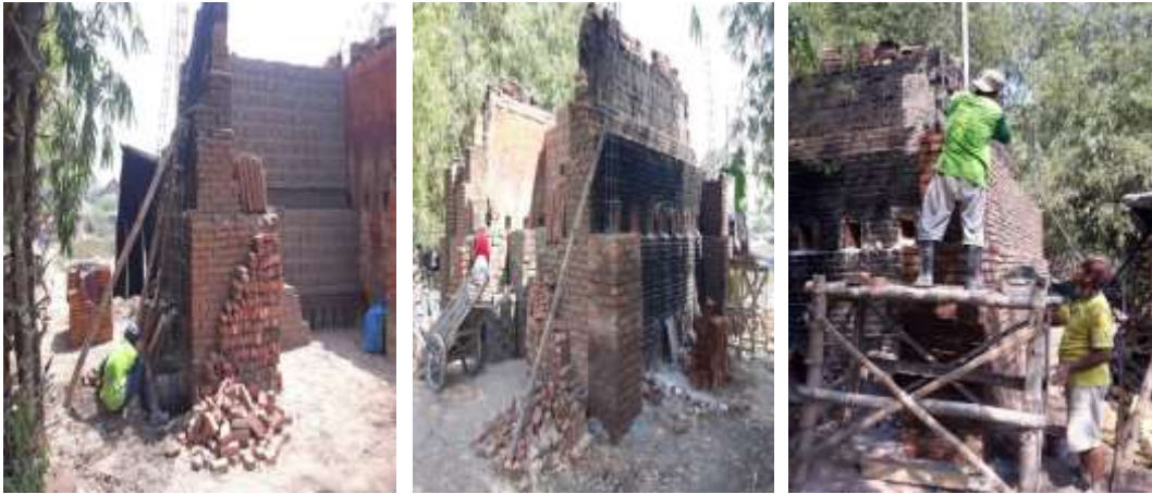
Gambar 27. Proses pembuatan cerobong pembakaran
