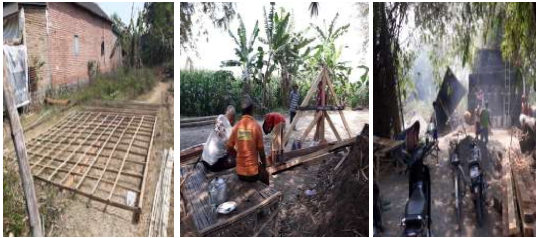
Gambar 25. Proses pembuatan cerobong pembakaran
