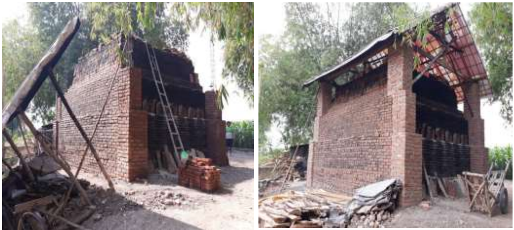
Gambar 28. Proses pembuatan cerobong pembakaran
