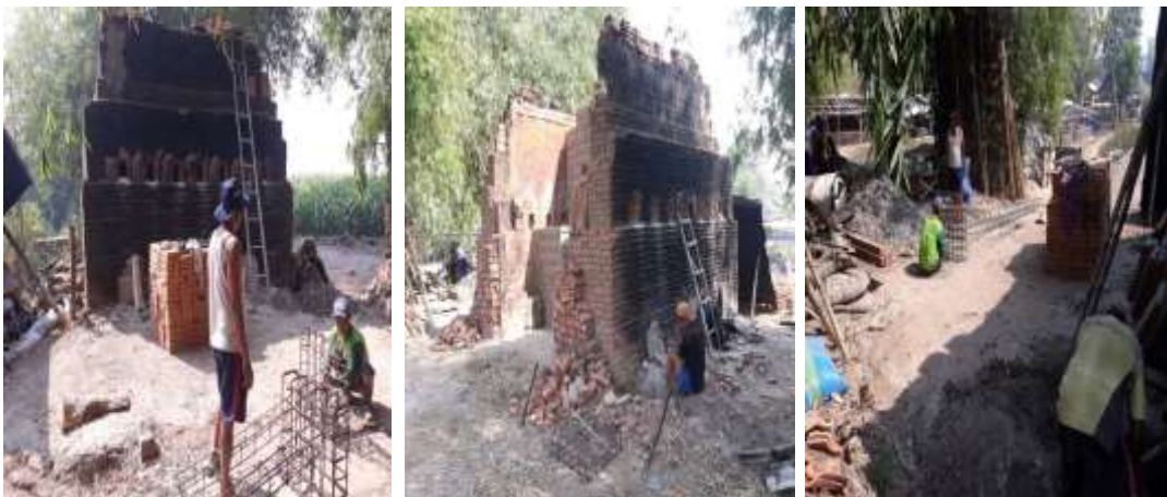
Gambar 26. Proses pembuatan cerobong pembakaran
