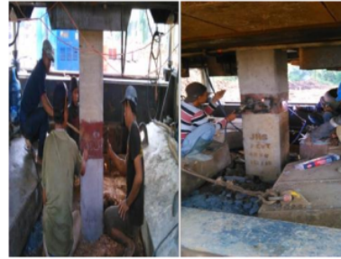
Gambar 4 Pengelasan tiang pancang
