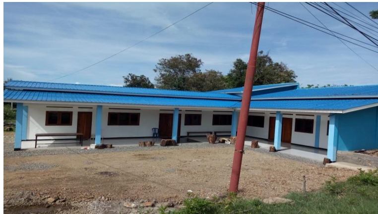
Gambar 2. Kantor PERUMDA Wae Mbeliling Manggarai Barat
