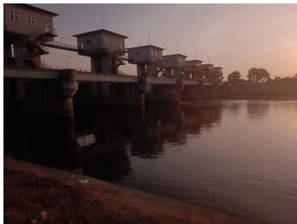
Gambar 4. 1. Bendung Gerak Sembayat Sumber : Dokumentasi (2021)
